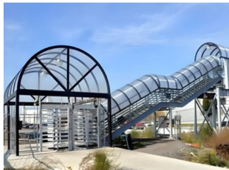
Mái che cầu vượt đi bộ
