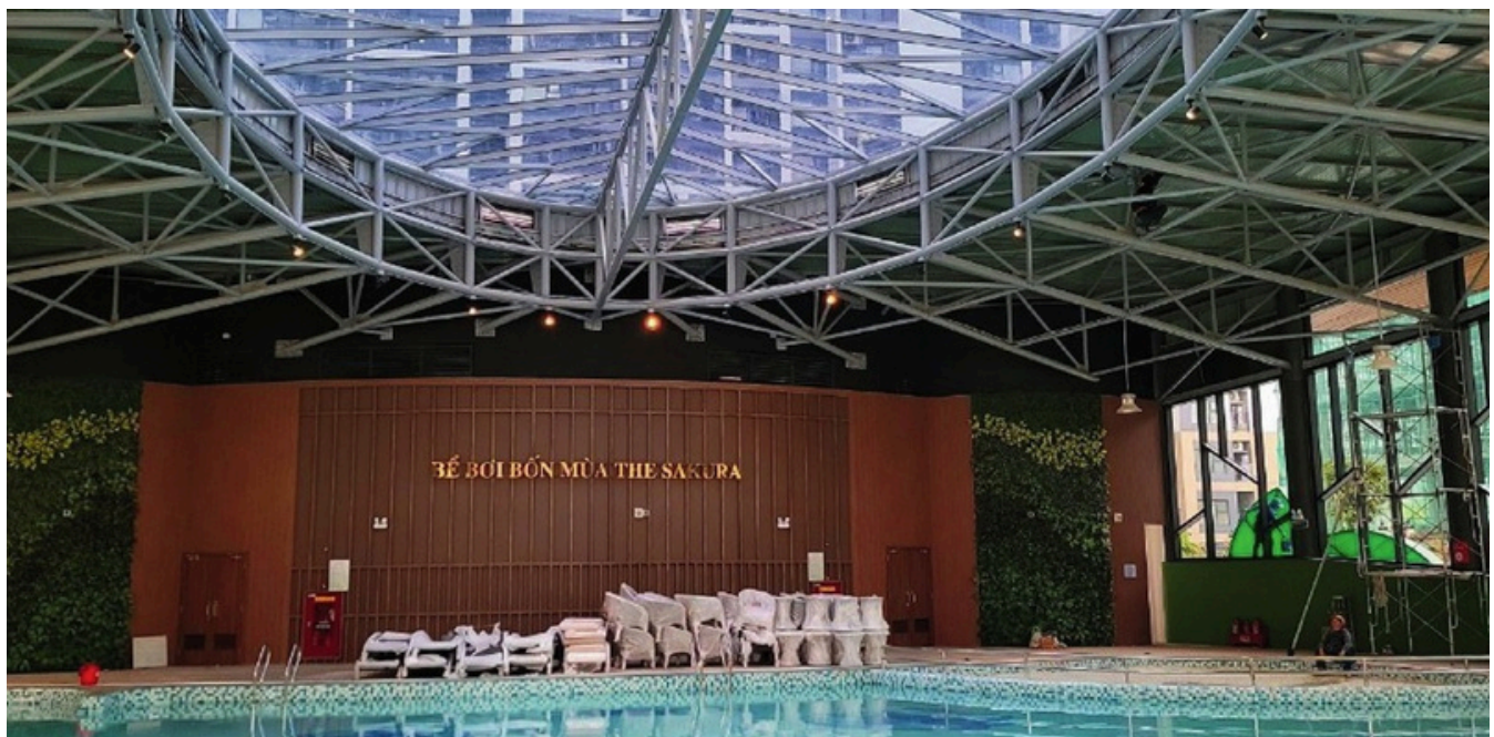
Mái che bể bơi bốn mùa The Sakura - Vinhomes Smart City Tây Mỗ (2024)
