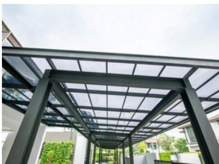
Mái sảnh, mái nhà để xe
