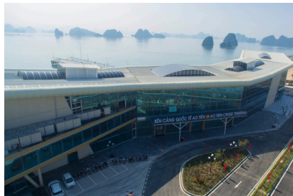
Dự án cảng tàu quốc tế Ao Tiên - Vân Đồn - TP Quảng Ninh
