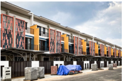
Dự án mái khu đô thị Suncasa Central - VSIP II - TP Bình Dương
