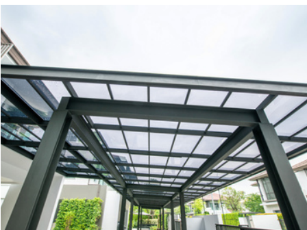
Mái sảnh, mái nhà để xe
