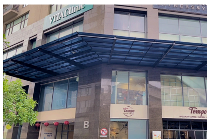
Mái sảnh chung cư cao cấp Sky Tower Số 88 Láng Hạ - Đống Đa - Hà Nội
