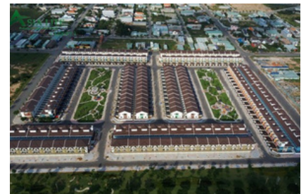
Dự án mái khu đô thị Suncasa Central - VSIP II - TP Bình Dương
