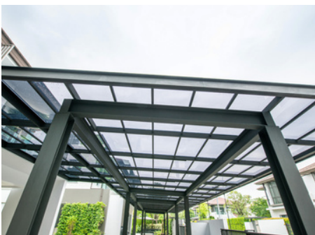
Mái sảnh, mái nhà để xe
