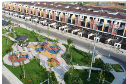
Dự án mái khu đô thị Suncasa Central - VSIP II - TP Bình Dương
