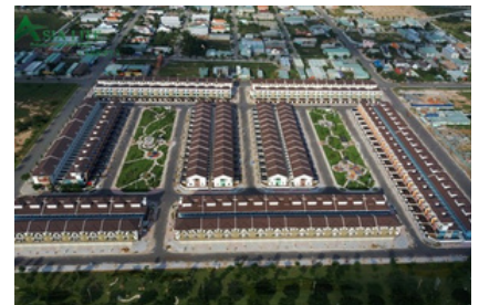
Dự án mái khu đô thị Suncasa Central - VSIP II - TP Bình Dương
