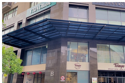
Mái sảnh chung cư cao cấp Sky Tower Số 88 Láng Hạ - Đống Đa - Hà Nội
